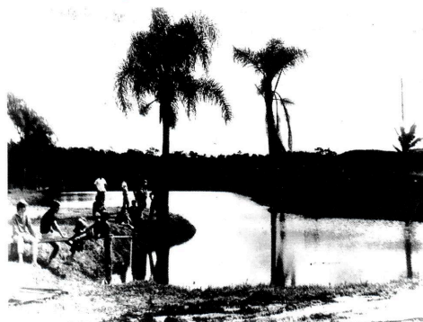
Construção do lago - 1976
